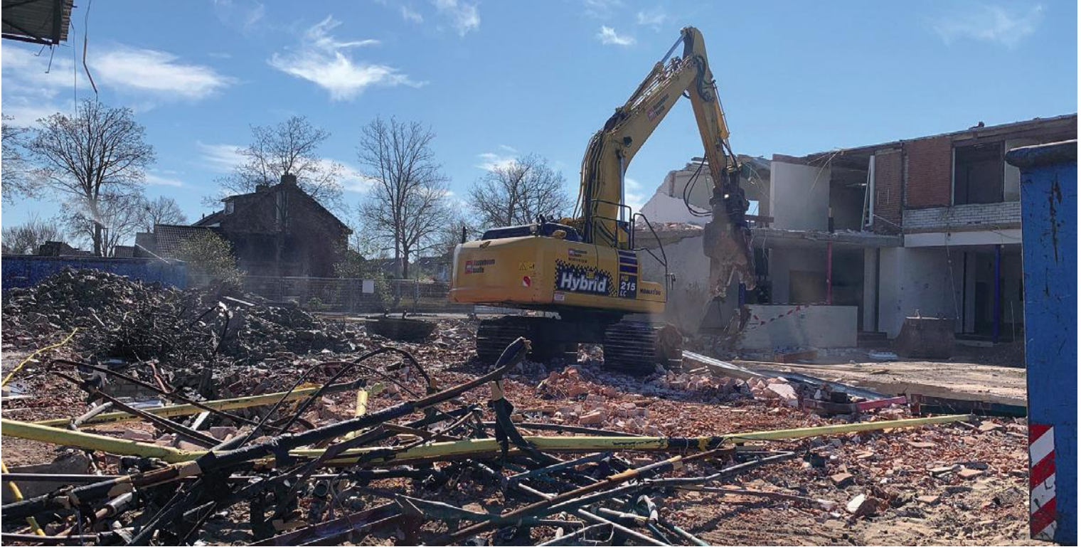
Demontage en scheiden van materialen.
