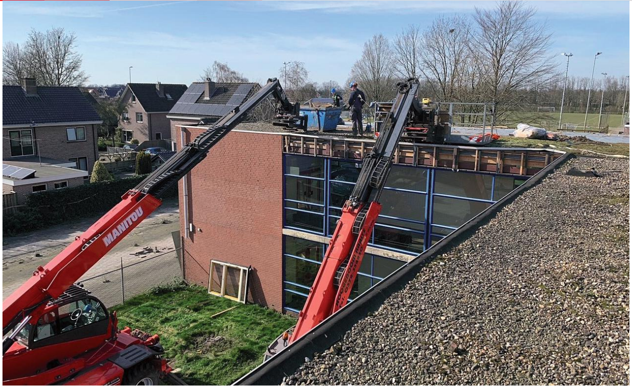
Verwijderen van het dakgrind.
