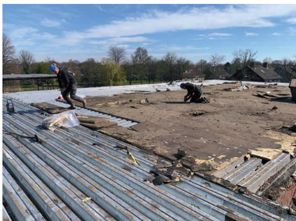
Demontage van dakisolatielaag.
