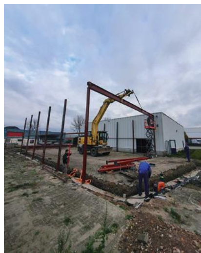
De staalconstructie van de gymzaal is gebruikt voor de bouw van een bedrijfshal. Links sloop en rechts herbouw.
