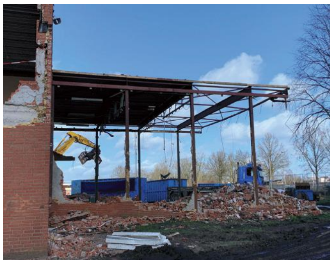
De staalconstructie van de gymzaal is gebruikt voor de bouw van een bedrijfshal. Links sloop en rechts herbouw.
